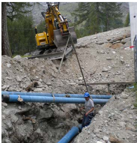
Rohrverlegung im Graben
