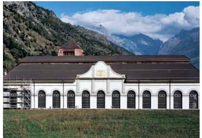
Steildacharbeiten, KW Ackersand, Stalden
