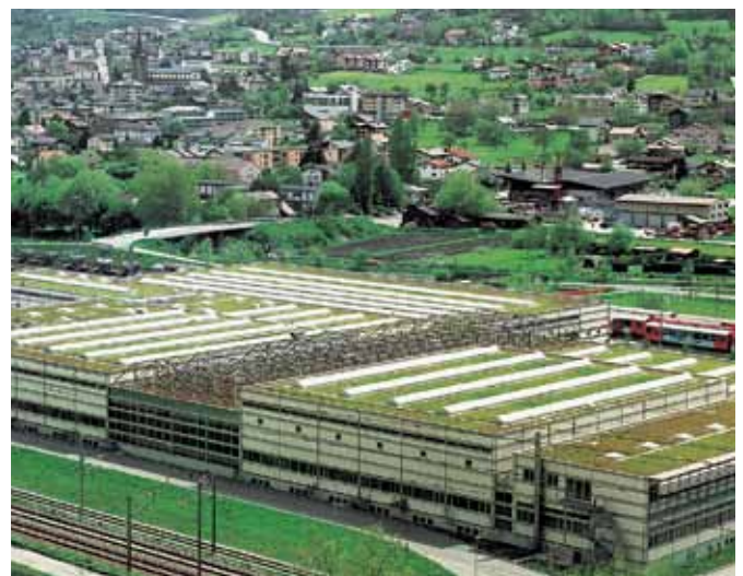
Depot Matterhorn Gotthard Bahn, Brig
