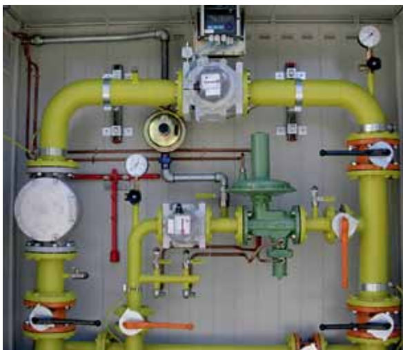
Erdgasleitung, EWBN, Brig
