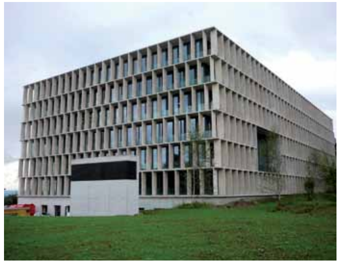
Information Science Lab, Minergie-ECO-Gebäude, ETH Höggerberg, Zürich
