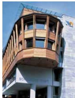
Verwaltungsgebäude EW Zermatt; Minergie-P
