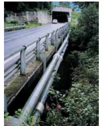
Kühlwasserleitung Stausee, Ferden
